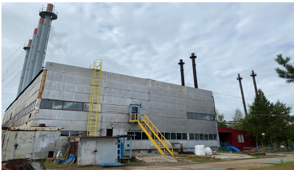
Рисунок 5. Внешний вид котельной №2
