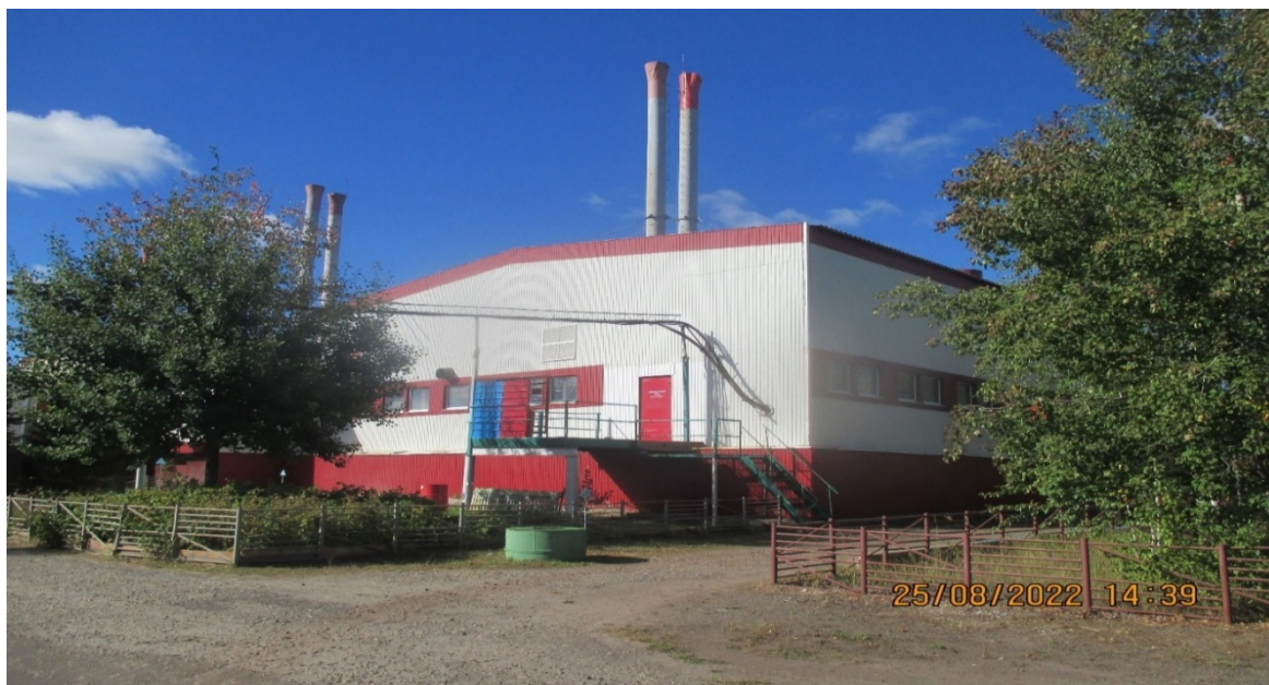
Рисунок 4. Внешний вид котельной №1
