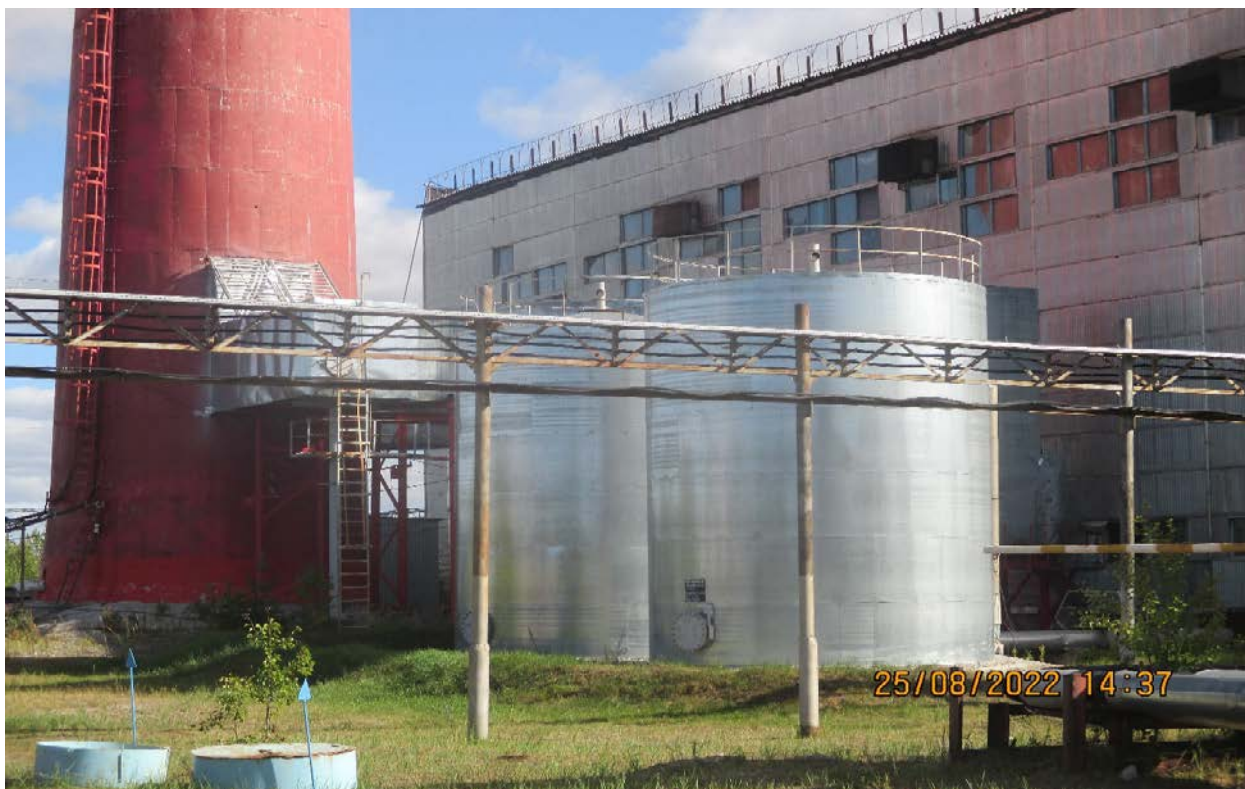
Рисунок 6. Внешний вид котельной №3
